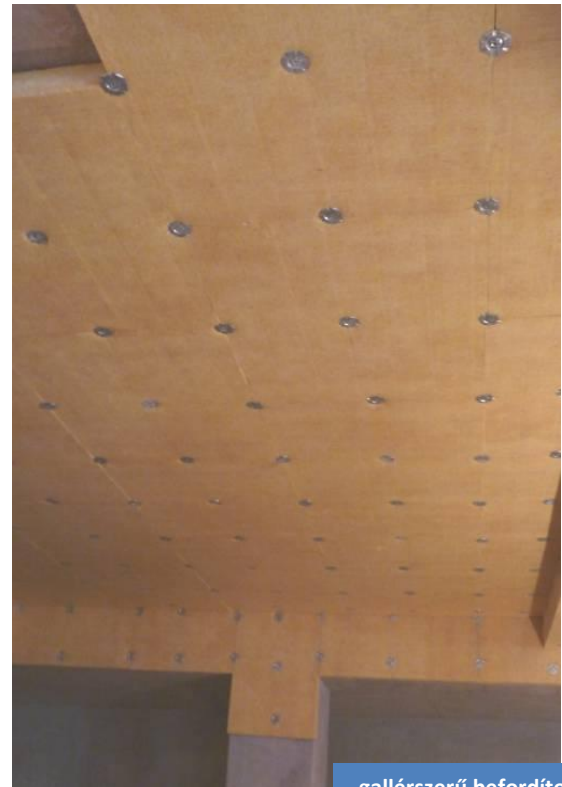
gallérszerű befördített pillérnyak hőszigetelés
