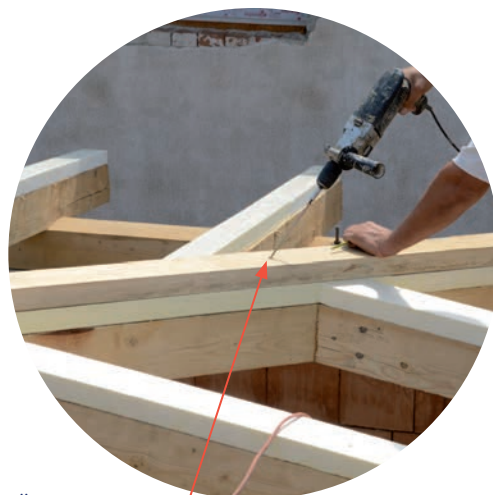
Süllyesztett fejű szerkezet-építő csavar
