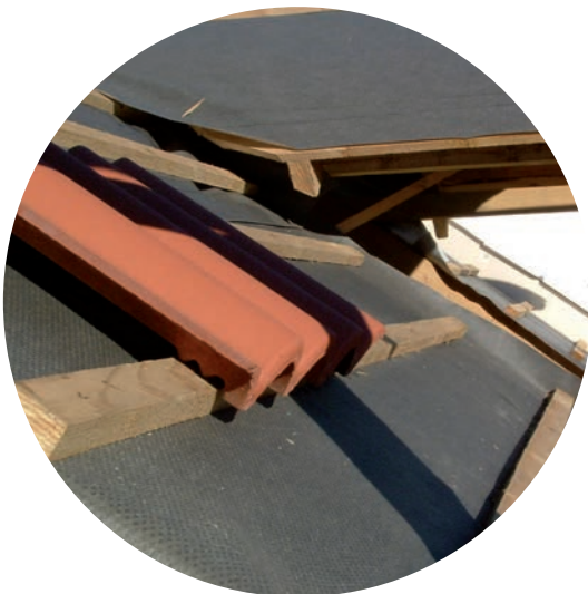
Az átszellőztetett fedési légrés hiánya
